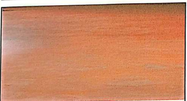
Foto 5: Reparación de piso tipo entortado de pintura roja
