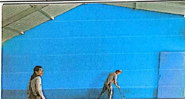
Foto 2: Reparación de pared de block
