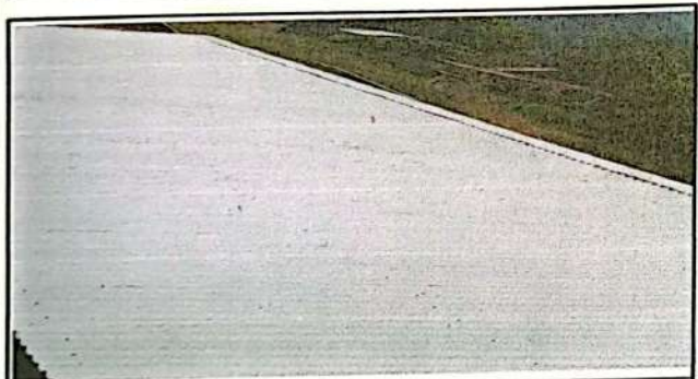
Foto 3: Instalación de laminas troqueladas
