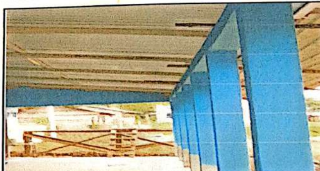
Foto 4: Reparación de Columnas de concreto
