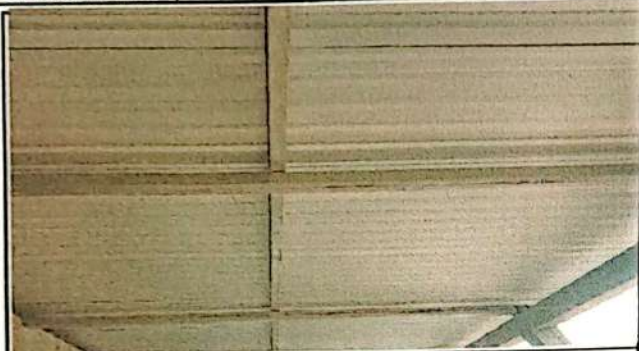
Foto 1: Reparación de costaneras de metal
